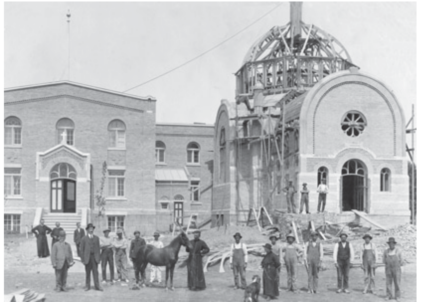
Bouw van een Oekraïense kloosterkerk in Yorkton (provincie Saskatchewan).
